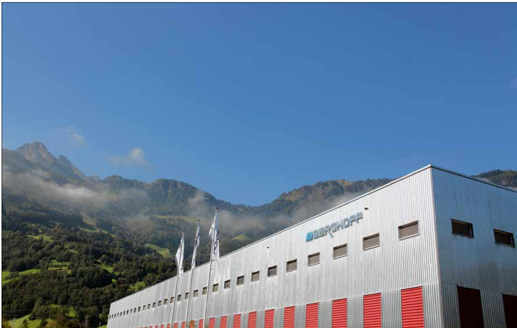
Das BERGHOFF-Firmengelände eingebettet in die schöne Bergwelt von Altdorf.
